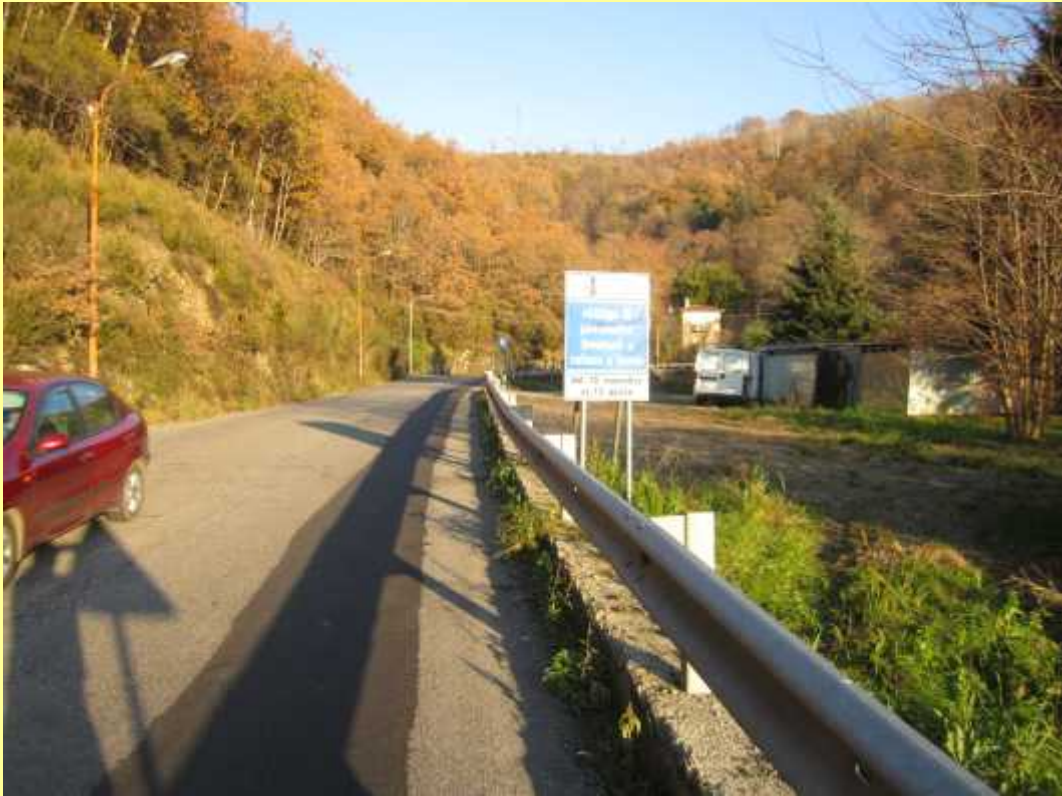
Foto 1 Vista area con viabilità
