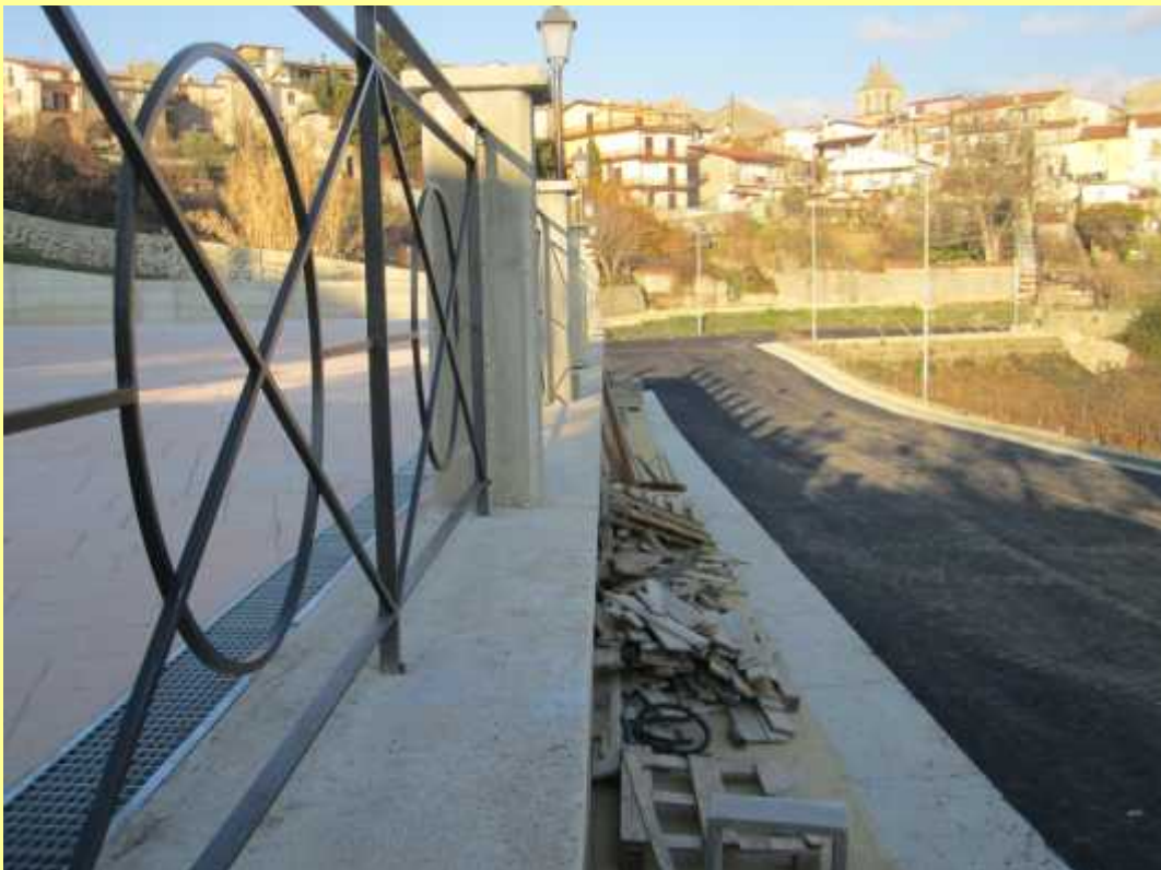
Foto 2 Particolare Strada e Parcheggio
